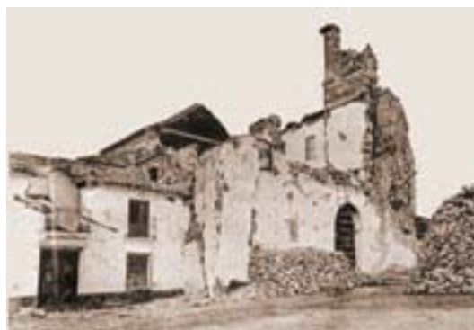
Iglesia y campanario después del terremoto de 1884. Fuente: Ayuntamiento de Periana
