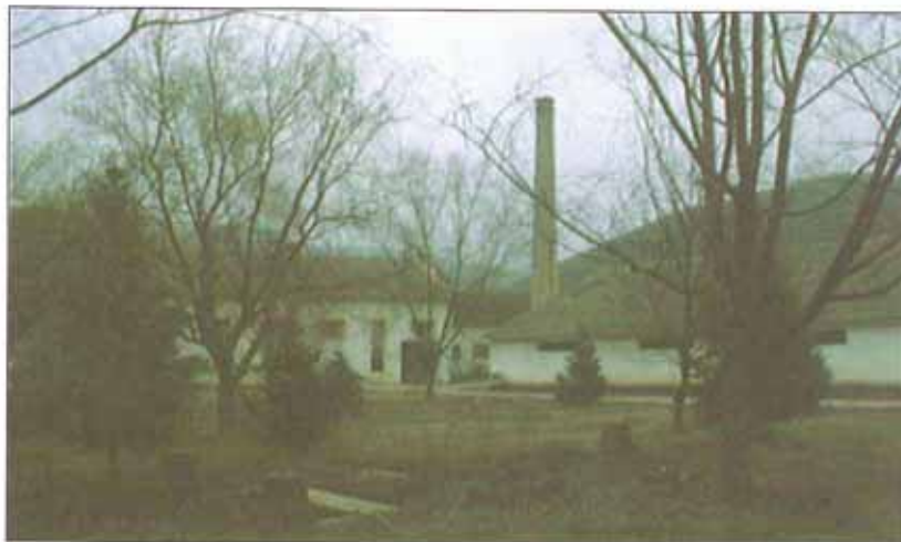
Instalaciones de La Resinera, industria del aguarrás
