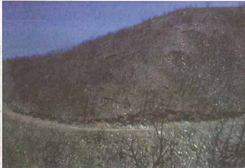
El incendio de agosto de 1999 dejó a la sierra expuesta a la erosión
